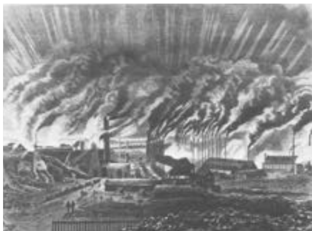
Σχήμα 1. Χαρακτική η οποία εμφανίζει ένα χυτήριο στην βιομηχανική περιοχή Saar της Γερμανίας (1876).
